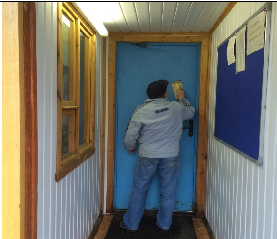
ГБОУ ДО ЦДТ «Строгино», 08.04.2017 Строгинский б-р, дом 17, корп.2 Подготовка к покраске входной двери на КПП
