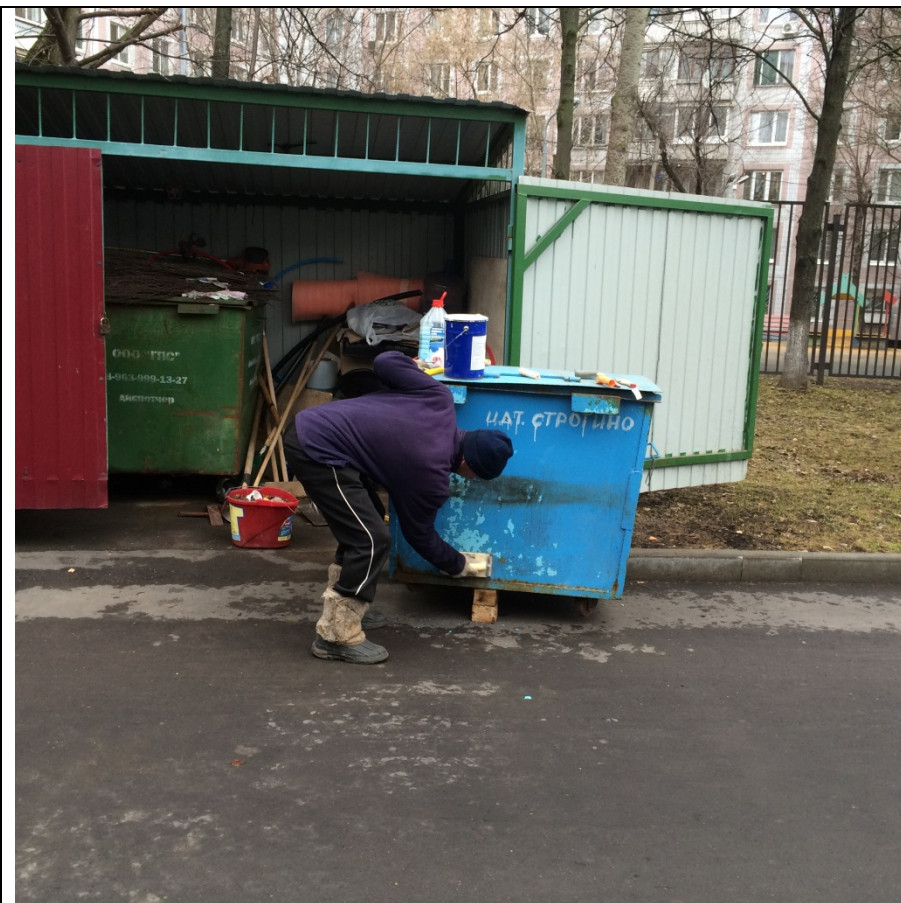
ГБОУ ДО ЦДТ «Строгино», 08.04.2017 Строгинский б-р, дом 17, корп.2 Подготовка к покраске мусорного контейнера
